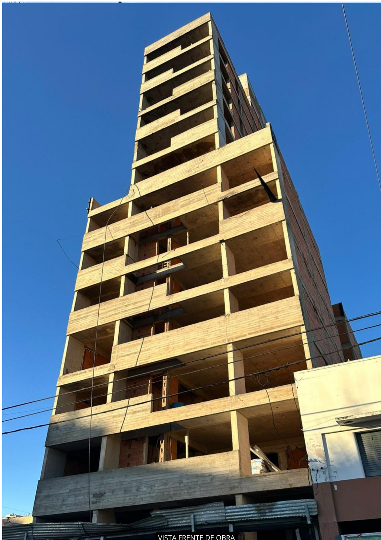
VISTA FRENTE DE OBRA
