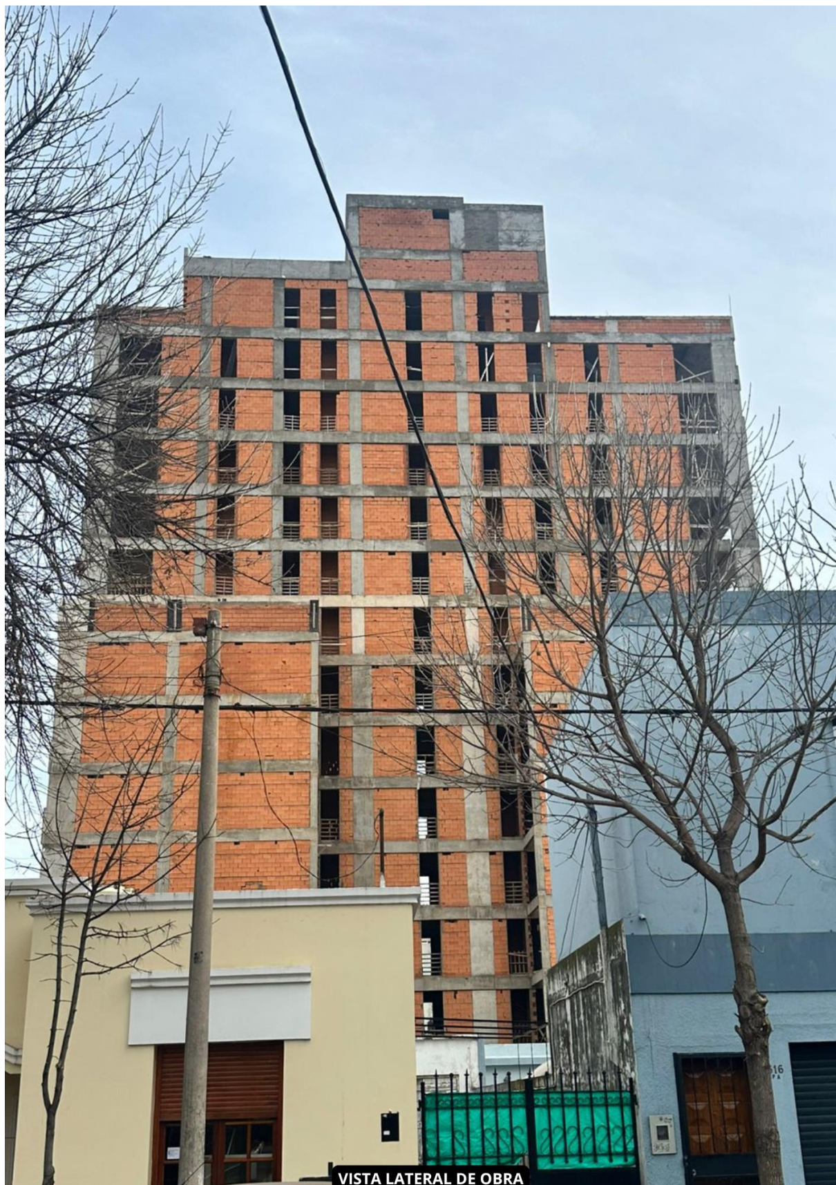
VISTA LATERAL DE OBRA
