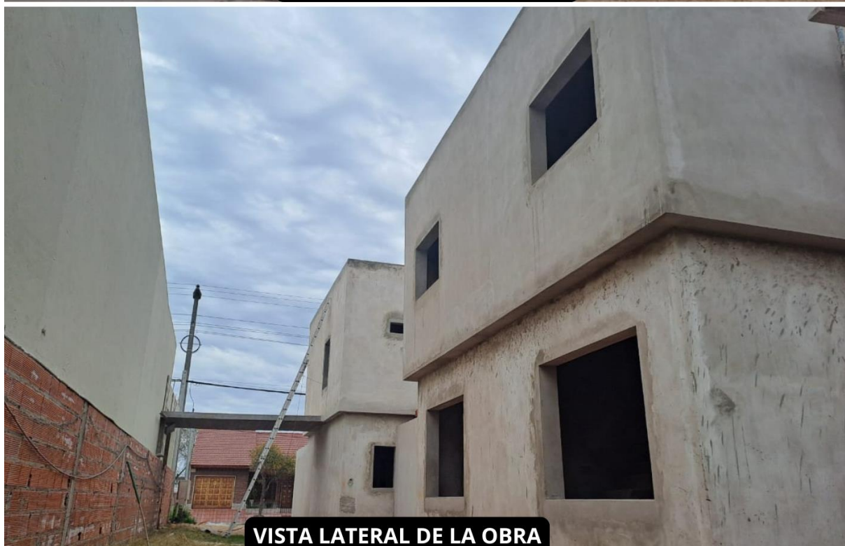
VISTA LATERAL DE LA OBRA
