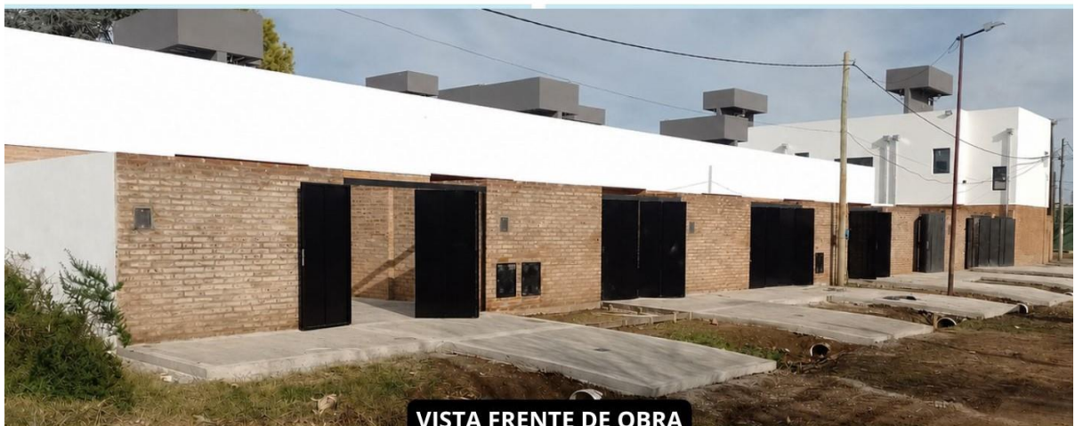
VISTA FRENTE DE OBRA
