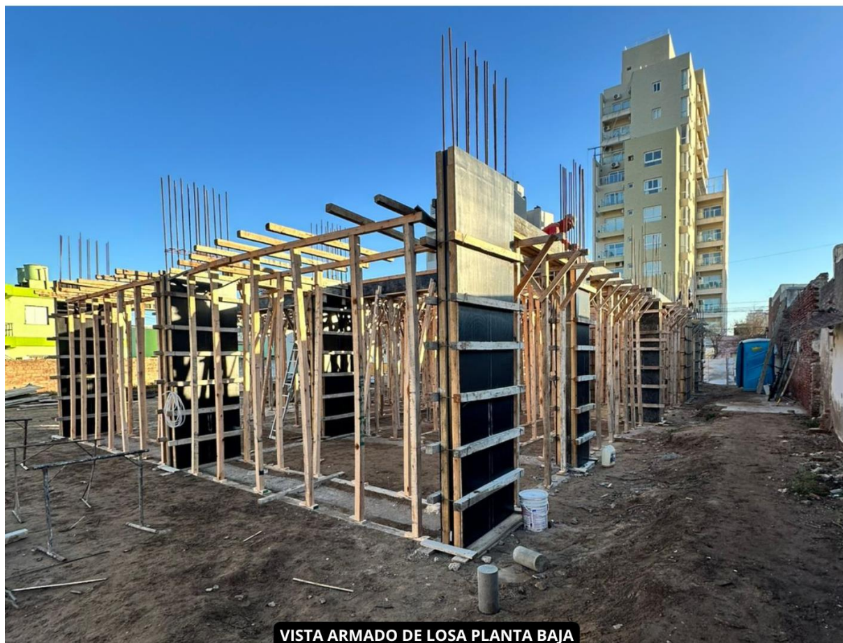
VISTA ARMADO DE LOSA PLANTA BAJA
